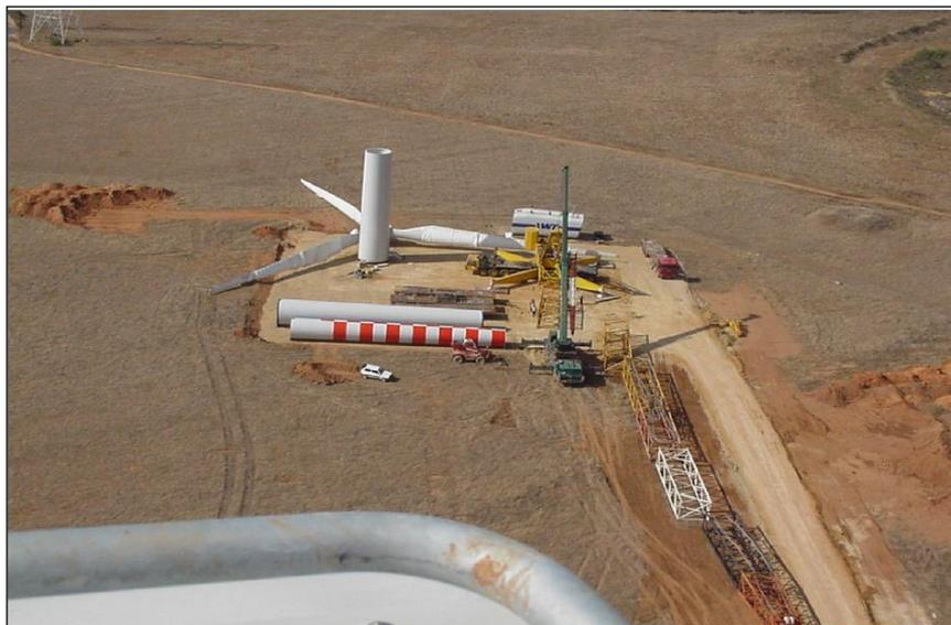
Foto 1. Piazzola per il montaggio dell'aerogeneratore
