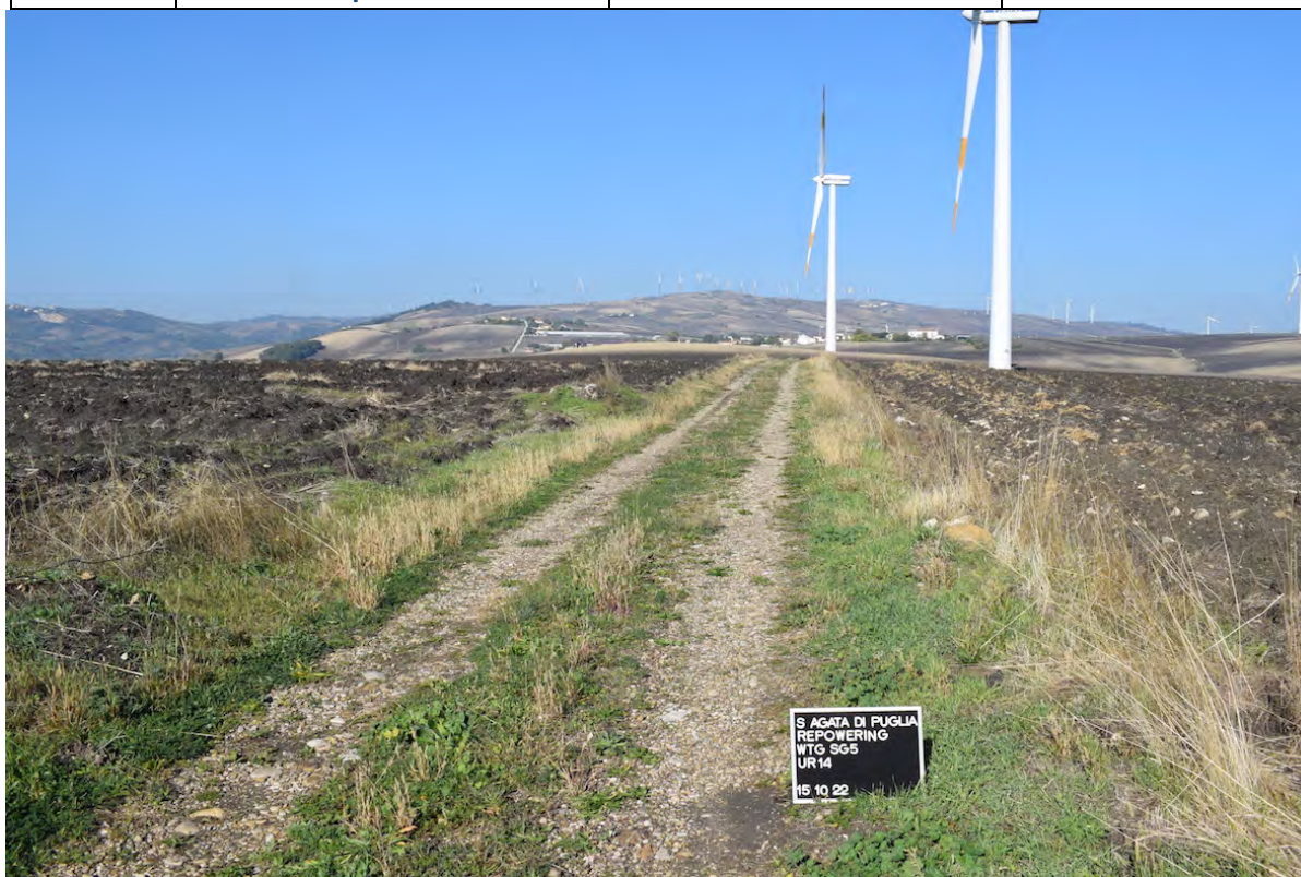
Foto 43 Cavidotto e pista di accesso Coordinate: 41°06'03.75"N 15°21'33.84"E
