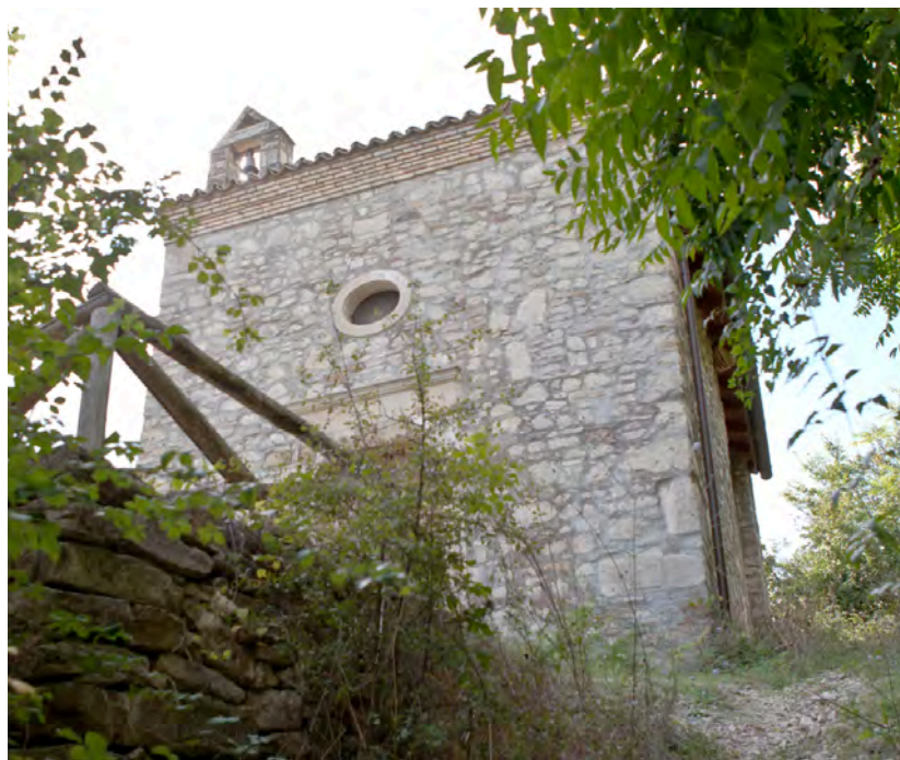
Fig.10 Accadia. S.Maria dei Teutoni. Reimpiego nella struttura di elementi lapidei di età romana
