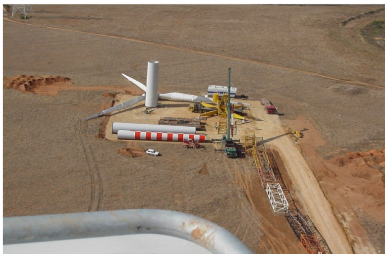
Figura 5 – Piazzola per il montaggio dell'aerogeneratore
