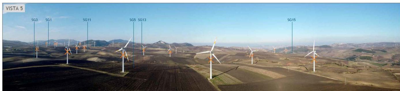
Figura 30 – Punto di vista aereo 5
