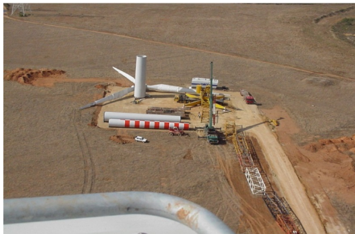
Figura 32 – Piazzola per il montaggio dell'aerogeneratore
