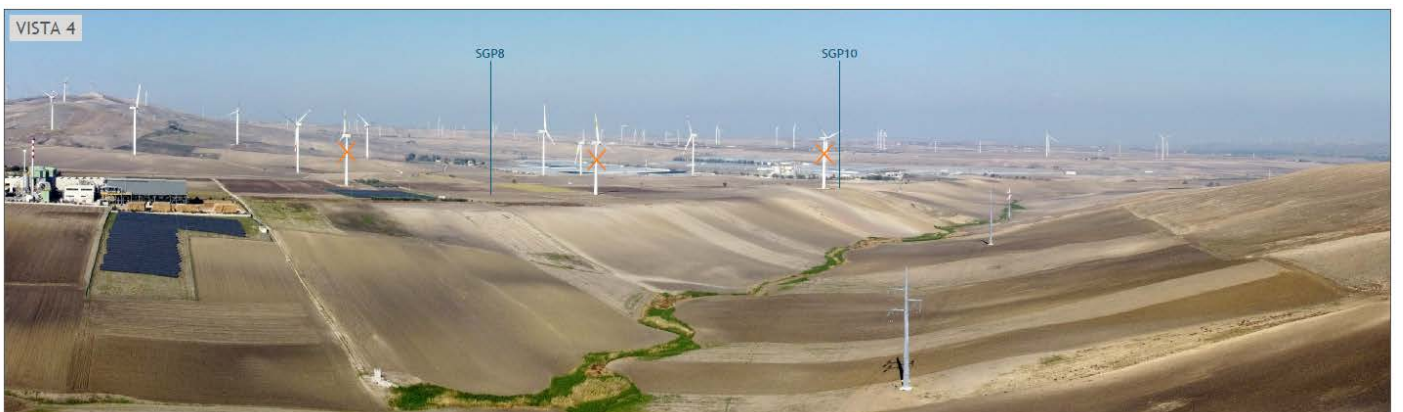
Figura 29 – Punto di vista aereo 4
