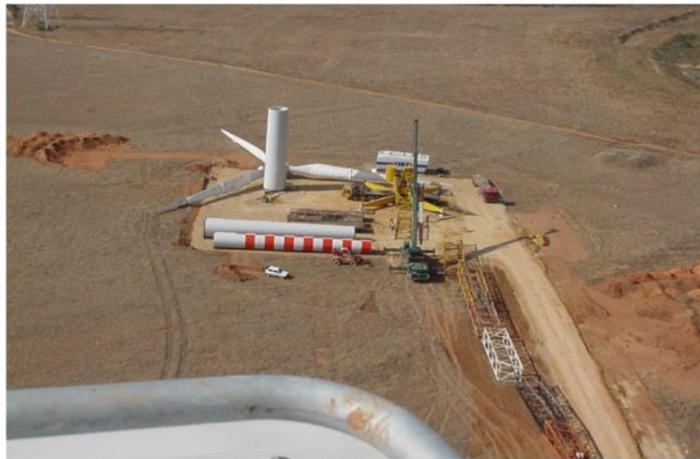
Figura 4 – Piazzola per il montaggio dell'aerogeneratore
