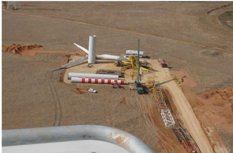
Figura 22 – Piazzola per il montaggio dell'aerogeneratore
