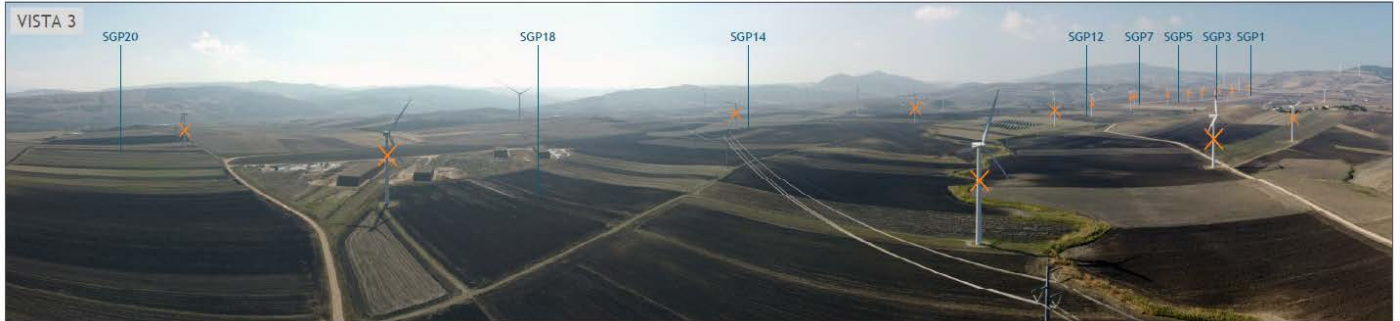
Figura 17 – Punto di vista aereo 3
