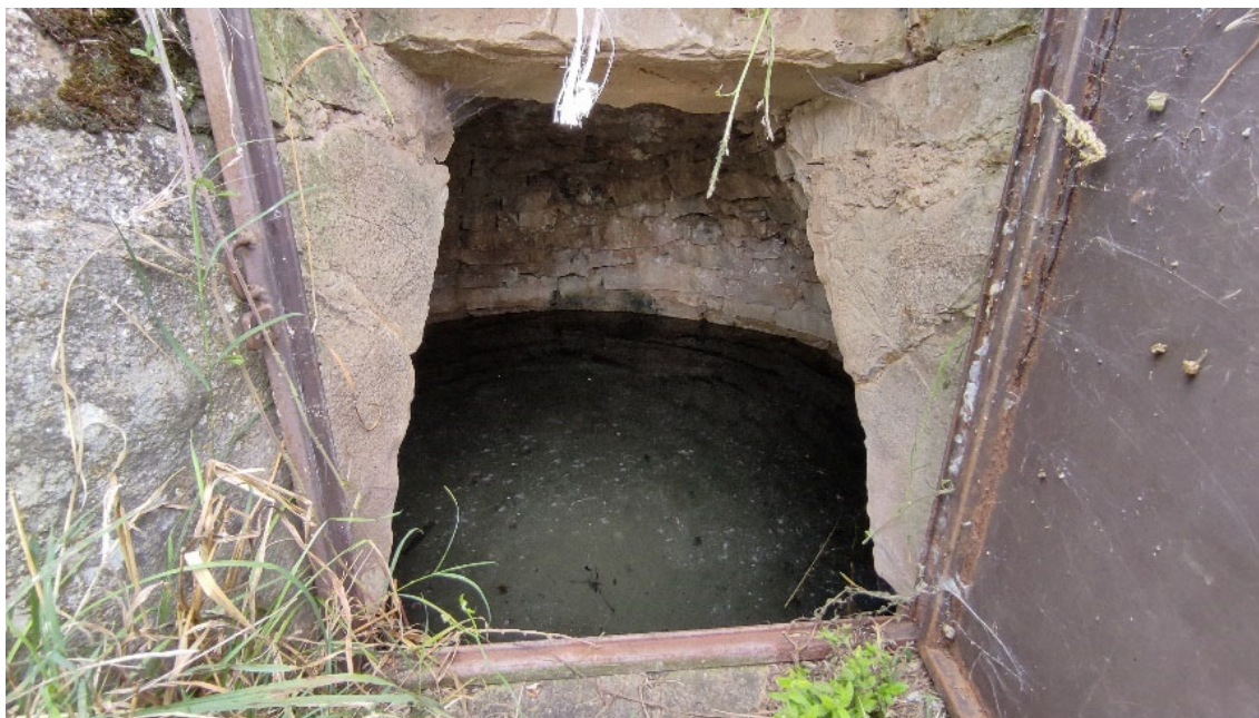
Figura 24 – Pozzo con falda presente a pochi centimetri dal piano campagna in località Pozzo Cupone
