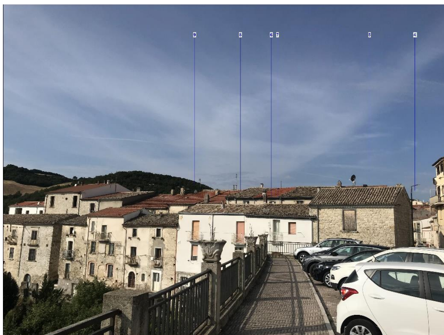
Figura 9– Punto POV2, Bonefro, Piazza del Municipio (foto in direzione sud sud-ovest). Rappresentazione fotografica ante operam e fotoinserimento.
