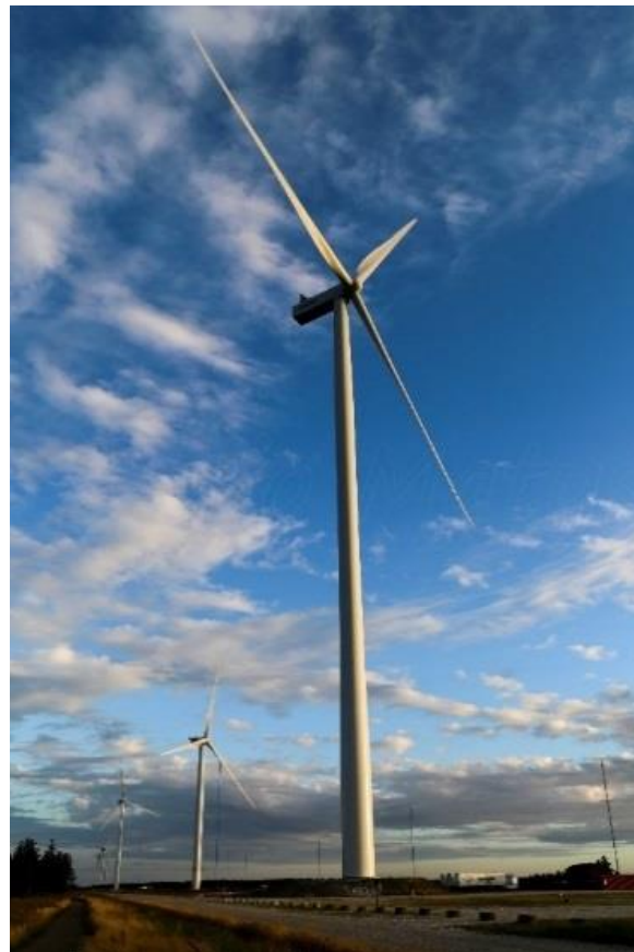
Figura 3 - Aerogeneratore Vestas V150 - 6 MW
