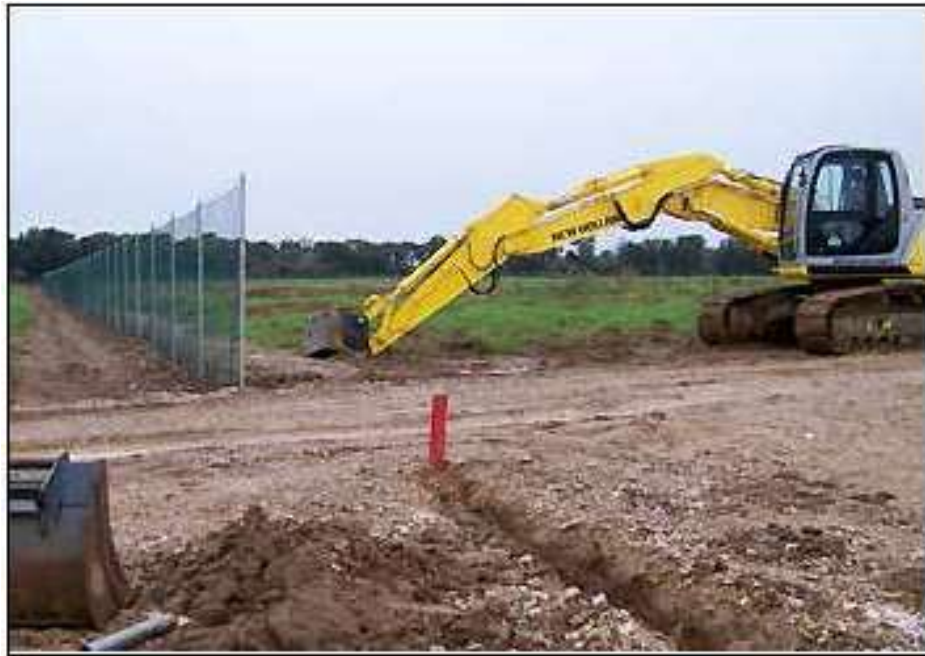
Fig. 5 Predisposizione della recinzione del parco fotovoltaico
