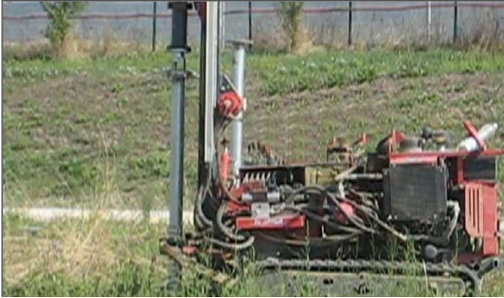
Fig. 2 inserimento pali di fondazione
