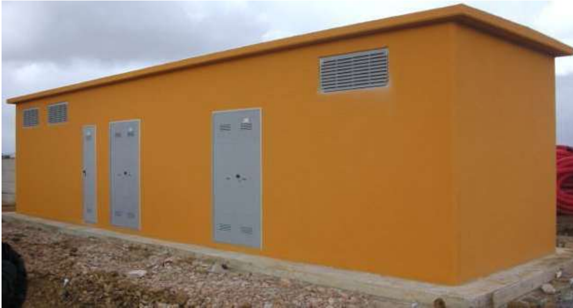
Fig.5 Posizionamento di una delle cabine elettriche
