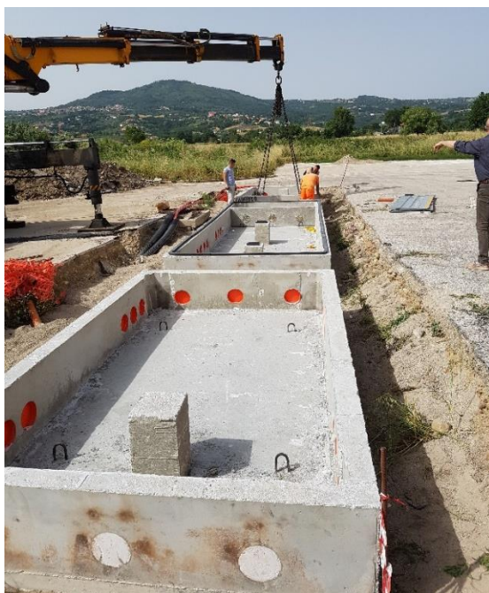
Figura 97 Esempio di basamento delle cabine
