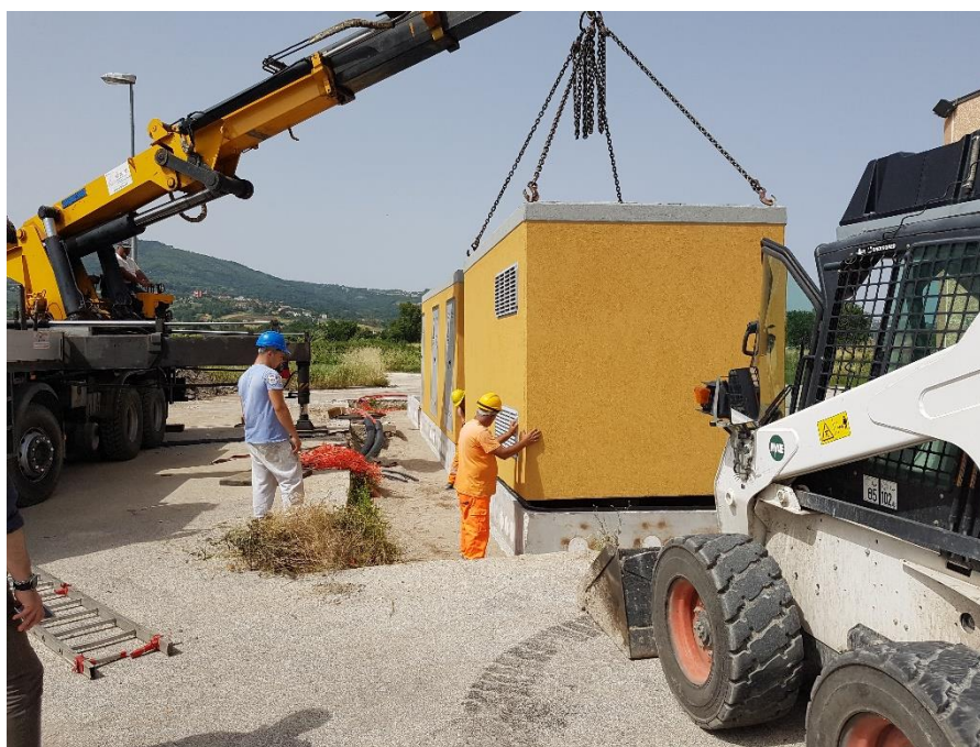
Figura 98 Esempio di posizionamento delle cabine
