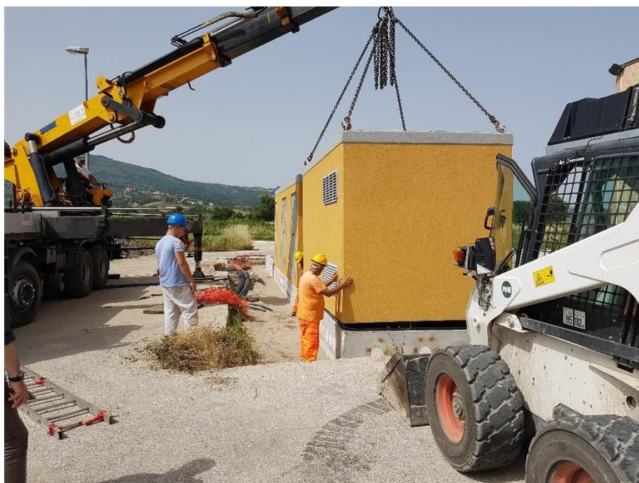
**Figura 19 Esempio di posizionamento delle cabine**
