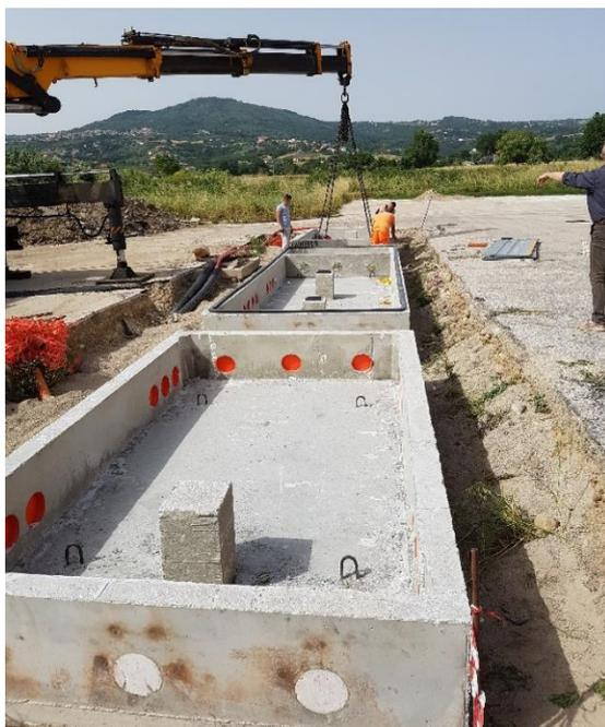
**Figura 18 Esempio di basamento delle cabine**
