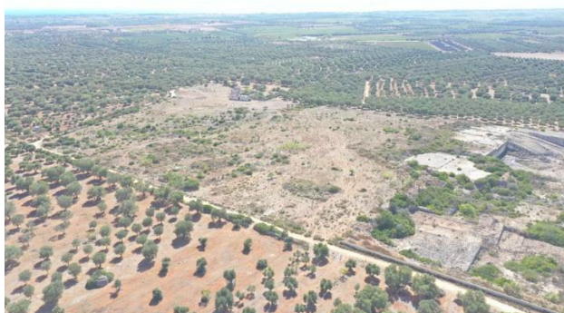
Figura 3: Vista panoramica dell'intera area d'intervento ripresa da est.
