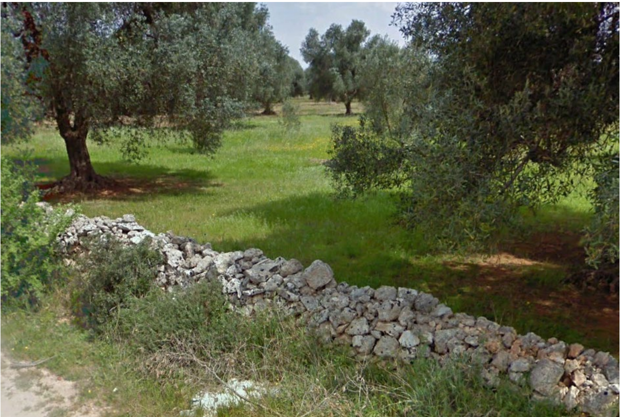
Muretti a secco
