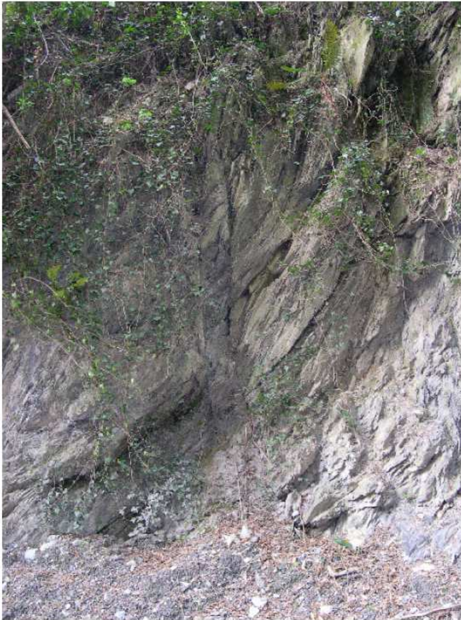
Fig. 3.6 – Faglia affiorante in corrispondenza degli affioramenti lungo il rio Mainose.
