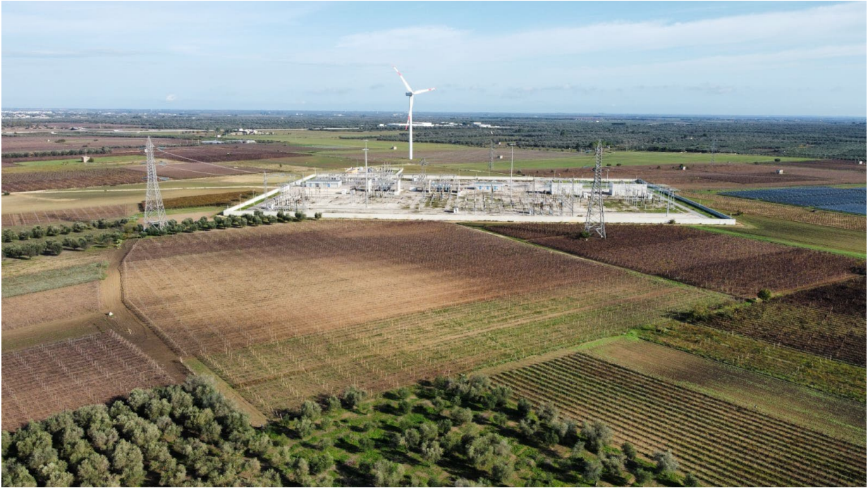
Ubicazione Stazione Elettrica 150/380 kV di Erchie (Br) a cui sara' collegata la SET Terna 36/380 kV
