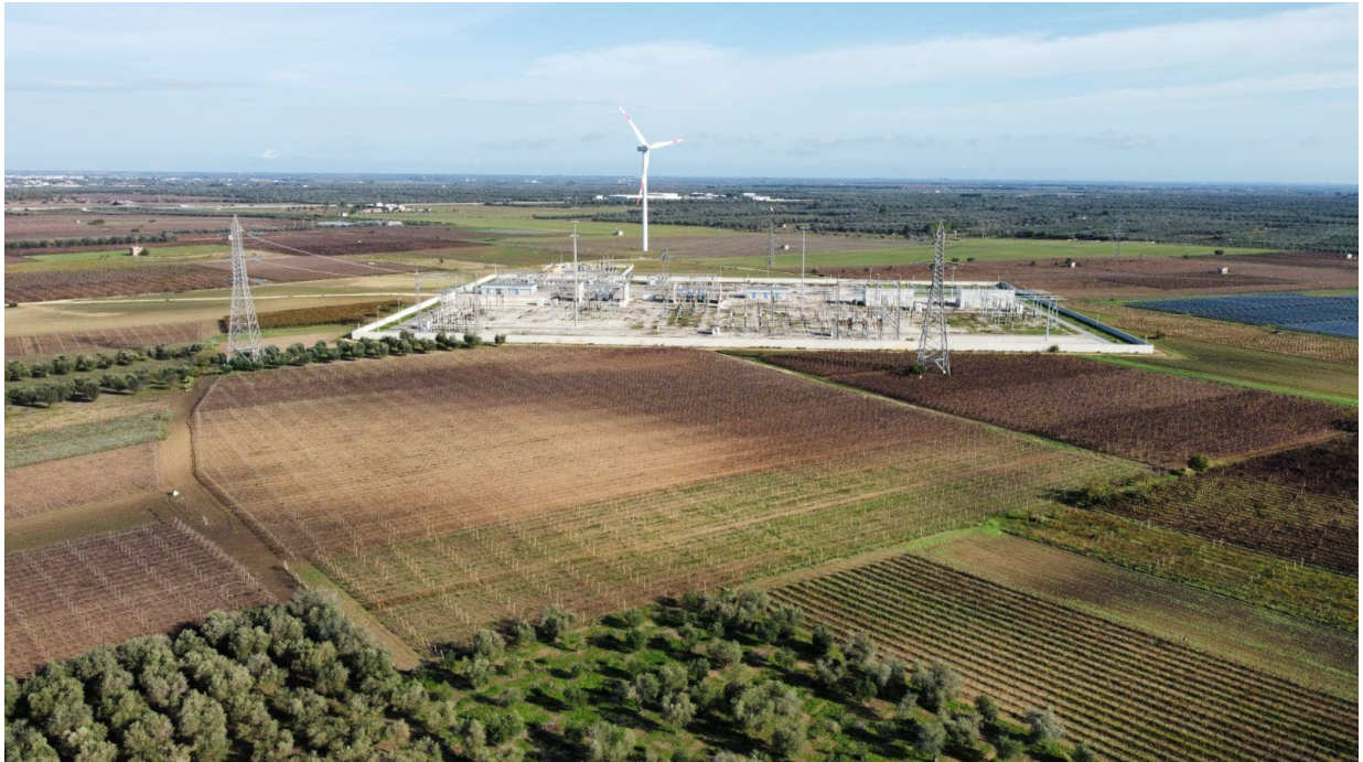
Ubicazione Stazione Elettrica 150/380 kV di Erchie (Br) a cui sara' collegata la SET Terna 36/380 kV
