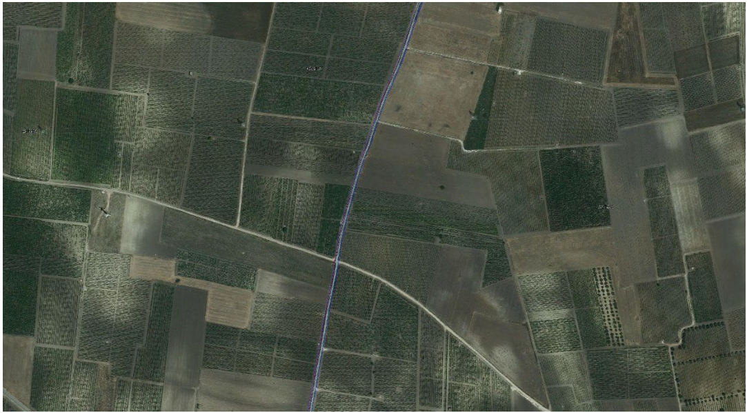
Ortofoto accesso da SP142 – figura 2 - Espianto e reimpianto vigneto 220 mq
