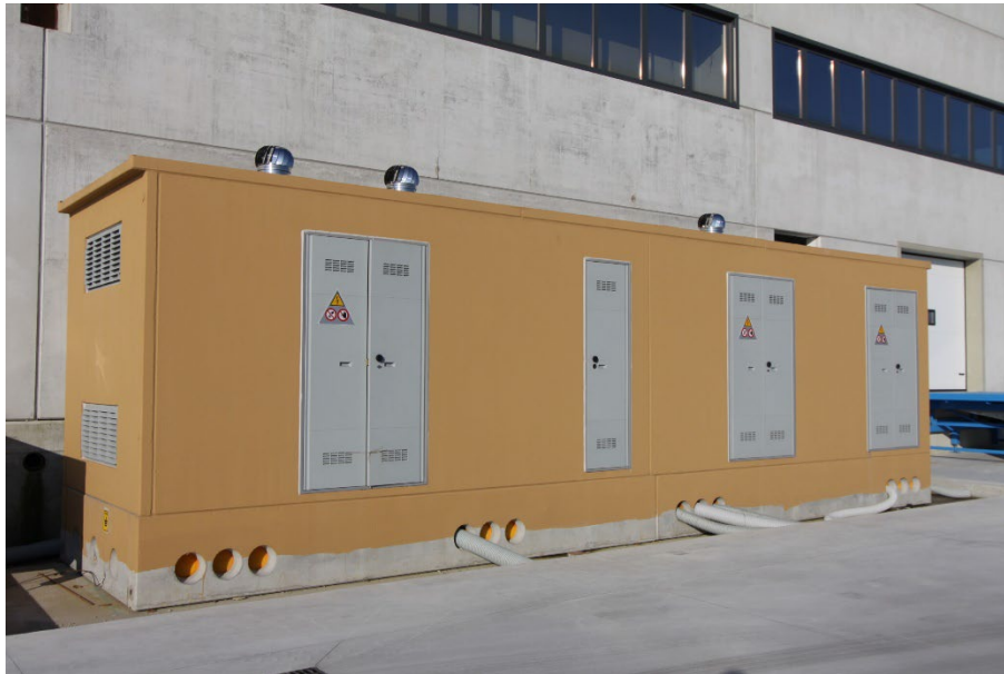
Fig.26 - Tipologia cabina di misura
