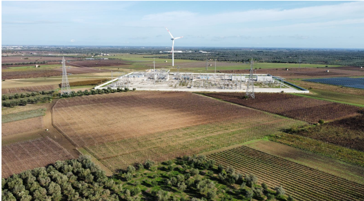
SE TERNA ERCHIE(BR) – La SET TERNA 36/380 sarà collegata con raccordi AT380
