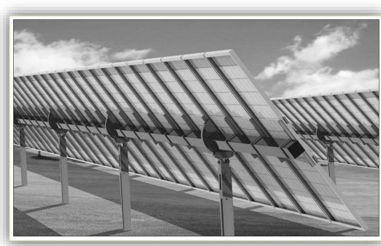
Fig. 1- Tracker - Inseguitore mono-assiale
