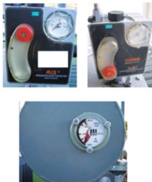
Figura 4.4: Verifica del livello dell'olio
