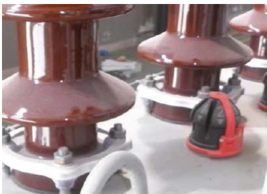
Figura 4.10: Dispositivi per movimentazione trasformatore
