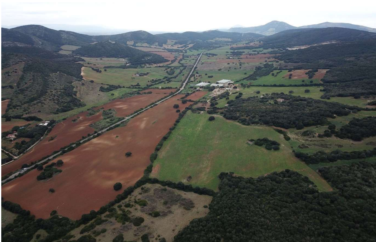
Figura 3.6-1 – Documentazione fotografica dell'area in cui sorgerà impianto agrivoltaico
