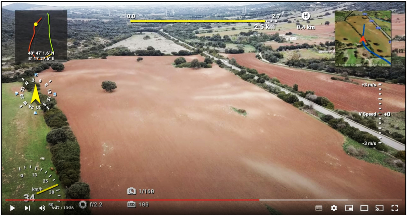
Figura 39. Riprese dal drone nell'area dell'impianto, vista verso NNE.
