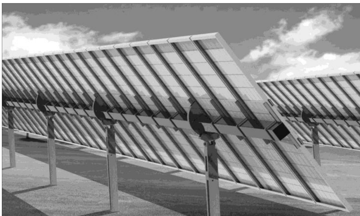
Figura 4: tracker: inseguitore monoassiale.
