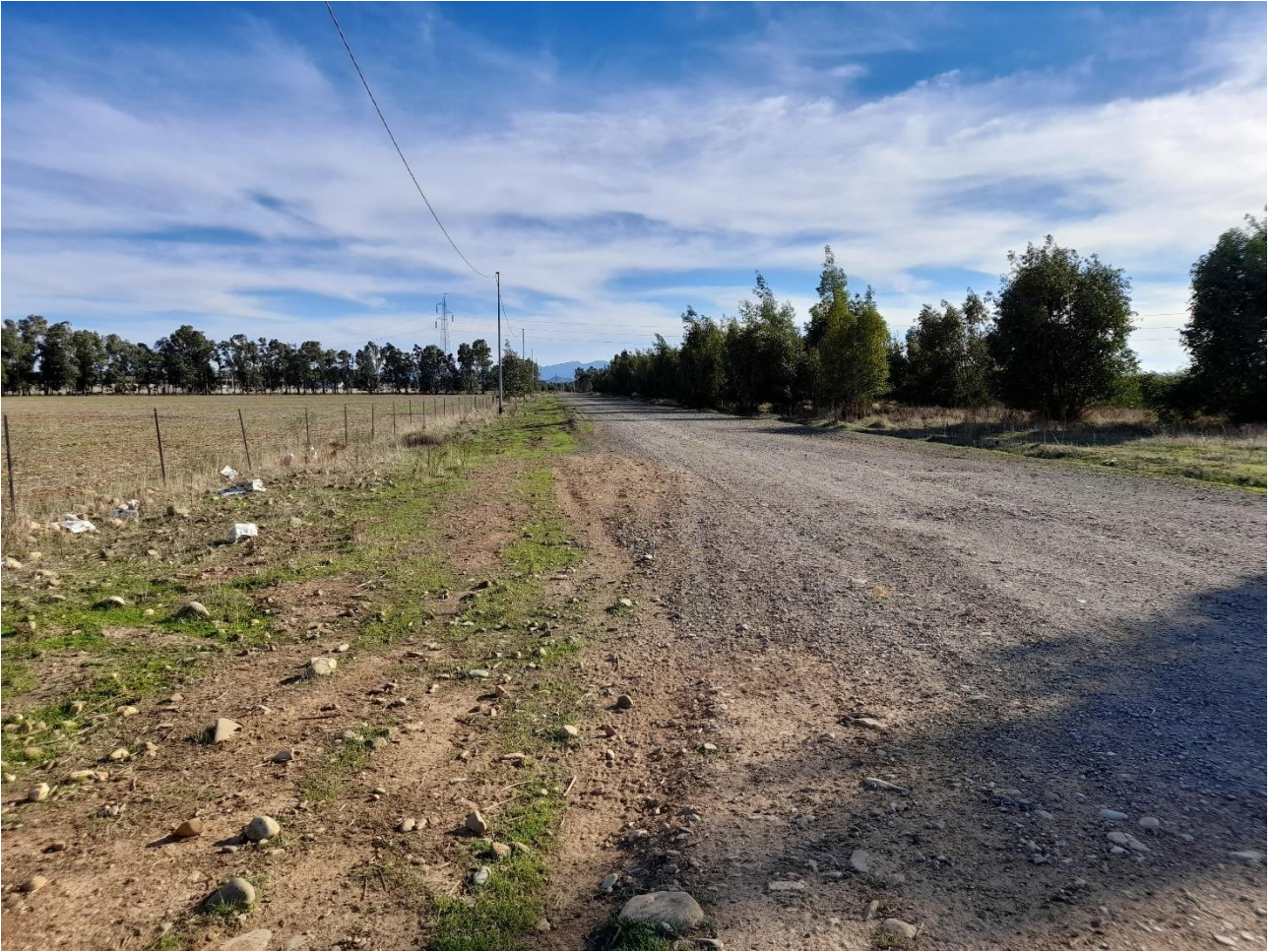
Figura 36 - Tratto I: P8 verso S
