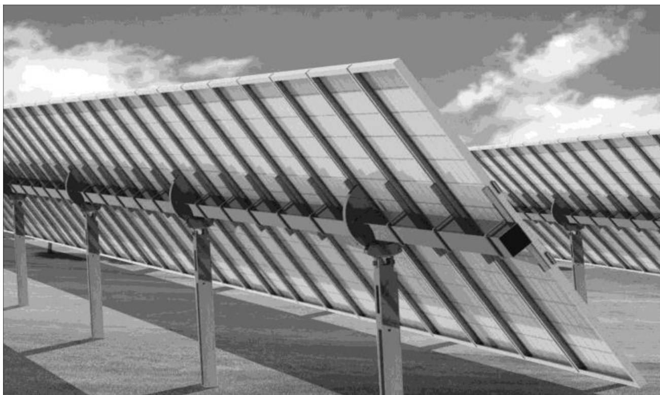
Figura 4: tracker: inseguitore monoassiale.
