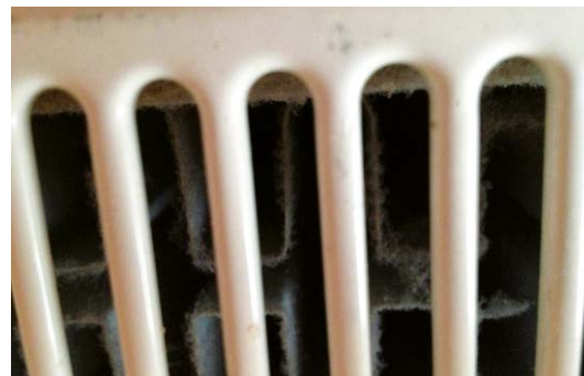
Figura 4.11: Stato di pulizia dei radiatori
