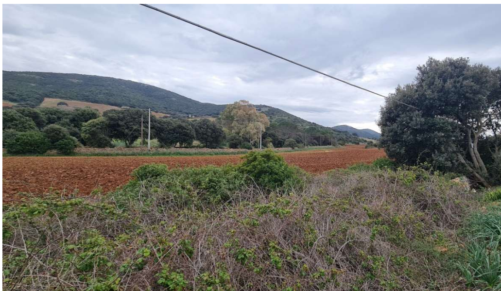
Figura 3.6-1 – Documentazione fotografica dell'area in cui sorgerà impianto agrivoltaico
