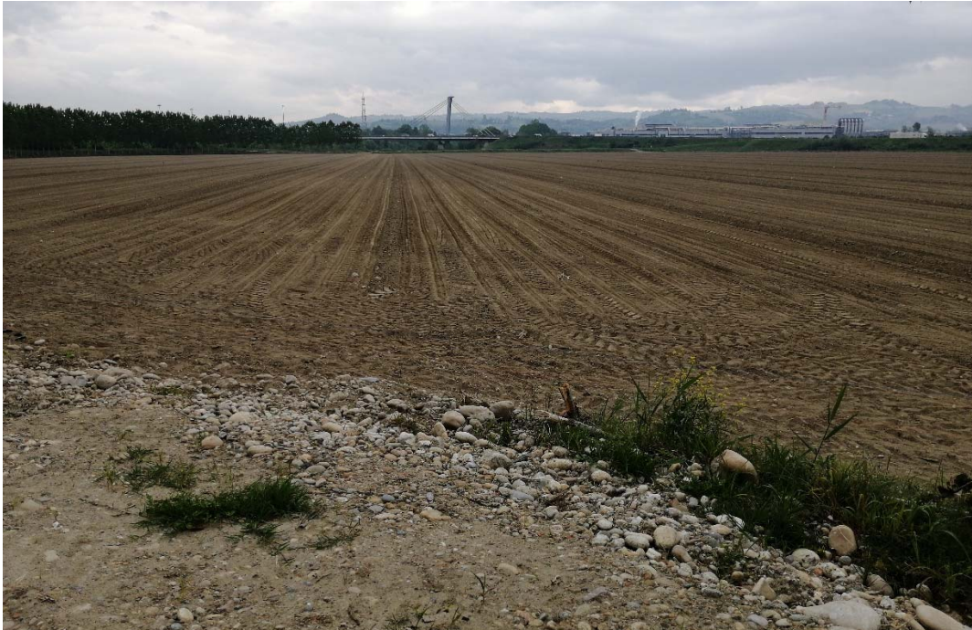
Figura 11: Depositi alluvionali attuali depositati durante uno degli ultimi eventi di piena. In primo piano: ghiaia e ciottoli lasciati da una rottura d'argine; sullo sfondo il ponte sul Fiume Tanaro appartenente alla Tangenziale di Alba.
