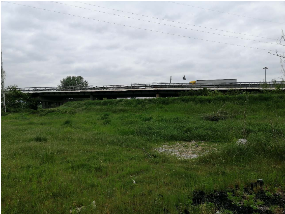
Figura 19: Viadotto in sponda sinistra del Fiume Tanaro appoggiato sui riporti.
