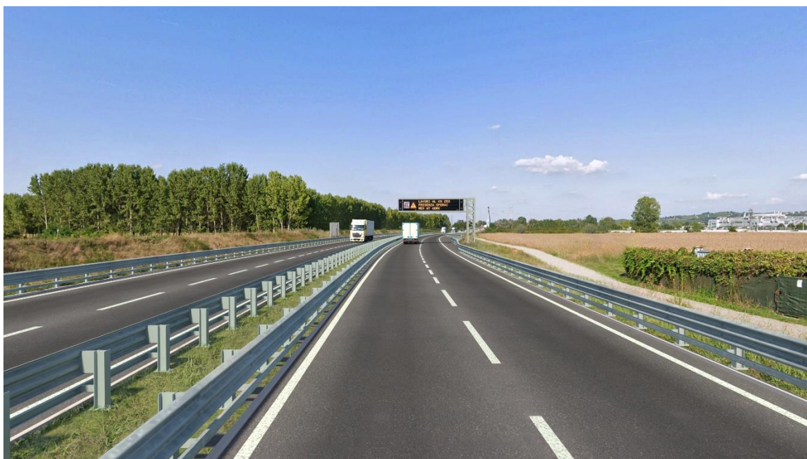
Figura 6-7 Punto di vista PV3 – nuove barriere di sicurezza (condizioni percettive post operam)
