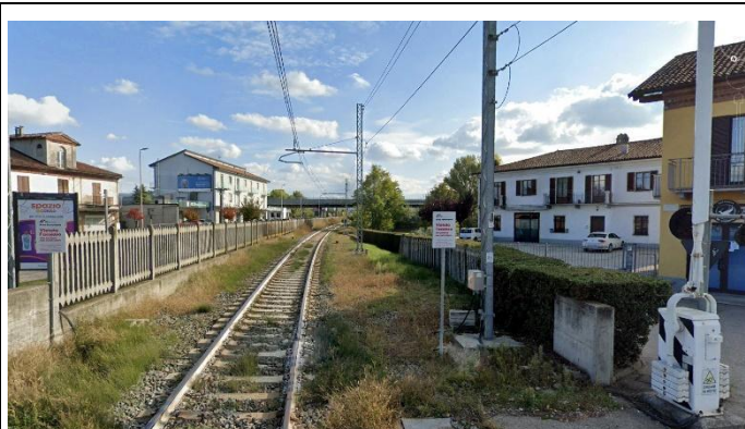
P8 – visuale parziale, zona di intervento parzialmente visibile a causa della presenza di manufatti, pali, recinzioni e alberature
