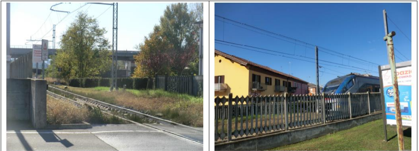
Linea ferroviaria Alba - Torino
