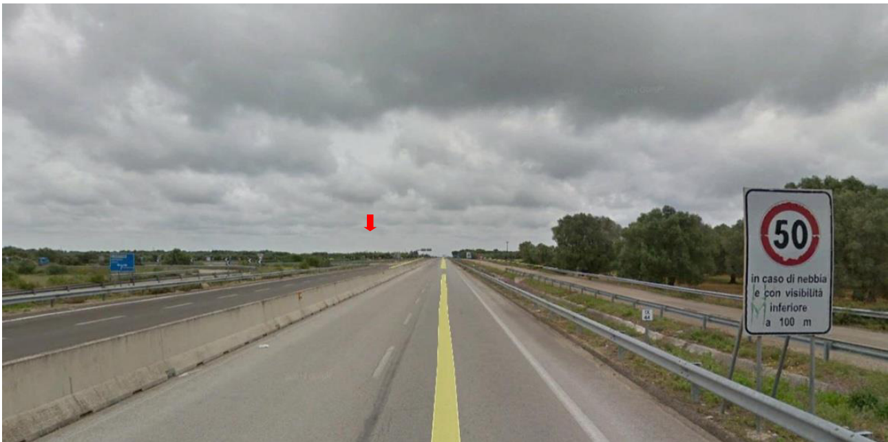
Figura 19 P.O.34: Strada Statale 7 Ter
