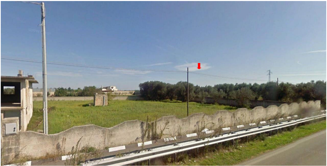
Figura 16 P.O.30: Strada Provinciale 64
