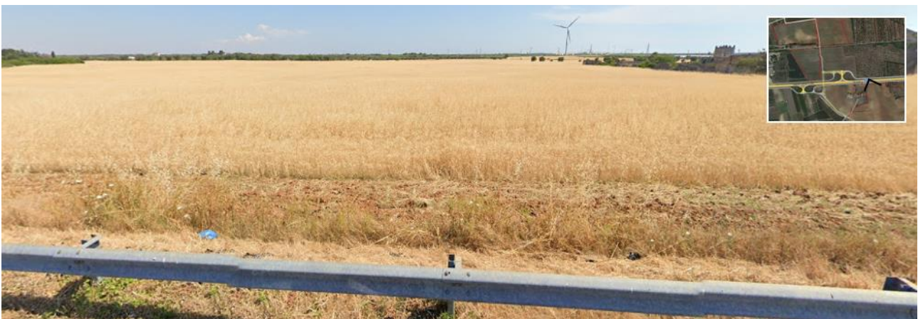
Foto: Vista dalla strada SS7ter - lotto 4 (giugno 2021)
