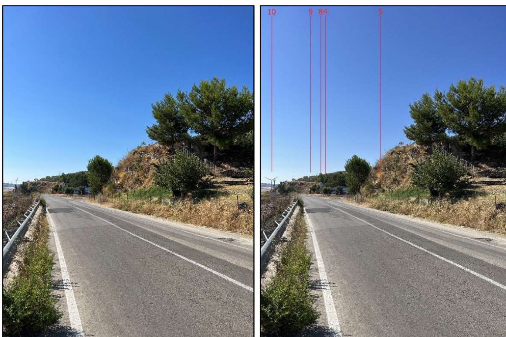
Scatto dal punto P10 (b): ante operam - post operam
