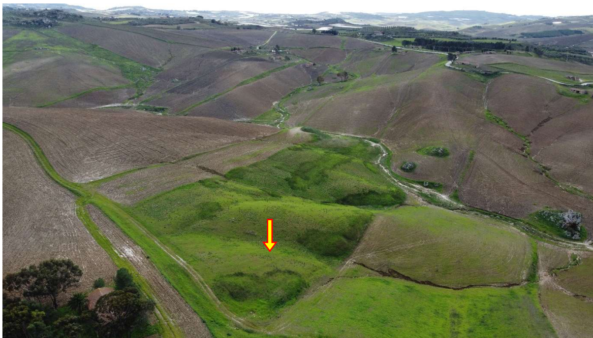
Figura 9: Vista dell'area di installazione aerogeneratore 08
