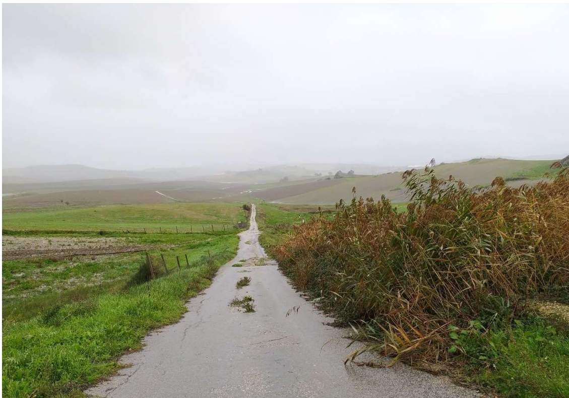
Figura 12: Tratto del cavidotto su strada esistente verso WTG 1
