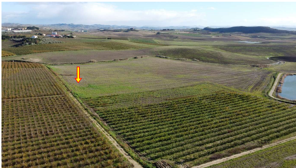
Figura 4: Vista dell'area di installazione aerogeneratore 02
