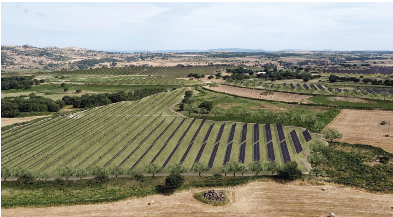
FIGURA 40 – INSERIMENTO DEL PROGETTO ALL'INTERNO DEL CONTESTO TERRITORIALE CON RELATIVE MISURE DI COMPENSAZIONE E MITIGAZIONE – VISTA A – ESTRATTO DALL'ELABORATO GRAFICO SIN4-IAT17
