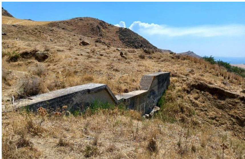
Figura 55: Foto briglia lungo il canale principale 1 del Lotto 5.
