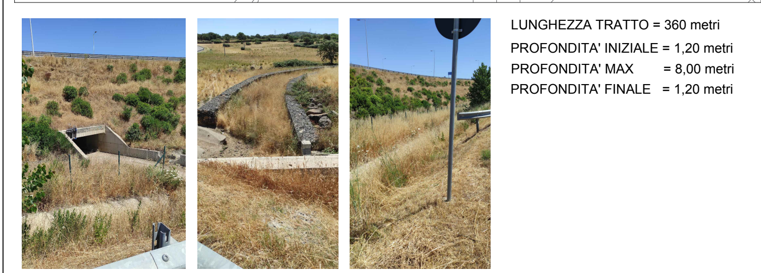
3 - ATTRAVERSAMENTO IN MICROTUNNELING - PER INTERFERENZA CON CORSO D'ACQUA E SVINCOLO
