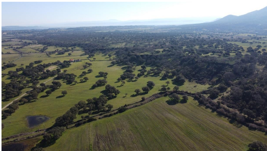
Zona con presenza della linea elettrica aerea in MT
