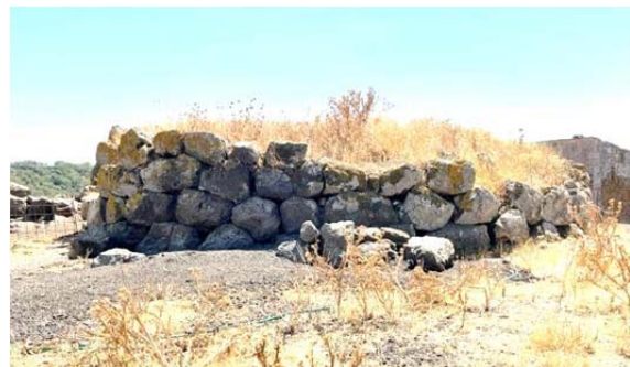
Fig. 21 Il mastio del Nuraghe Santu Filighe
