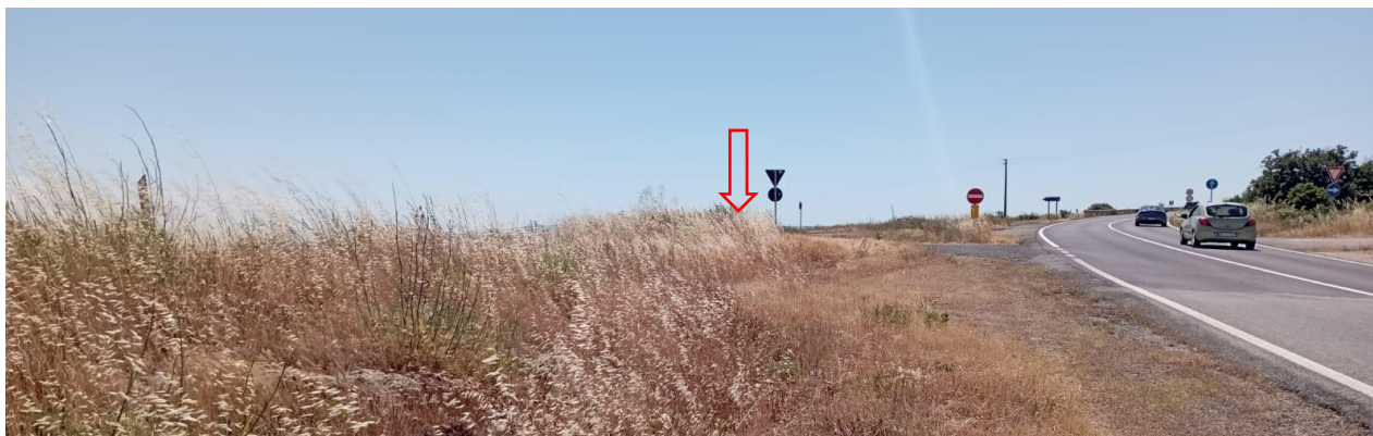
FIGURA 42: PUNTO DI VISTA N.6 – SS129
