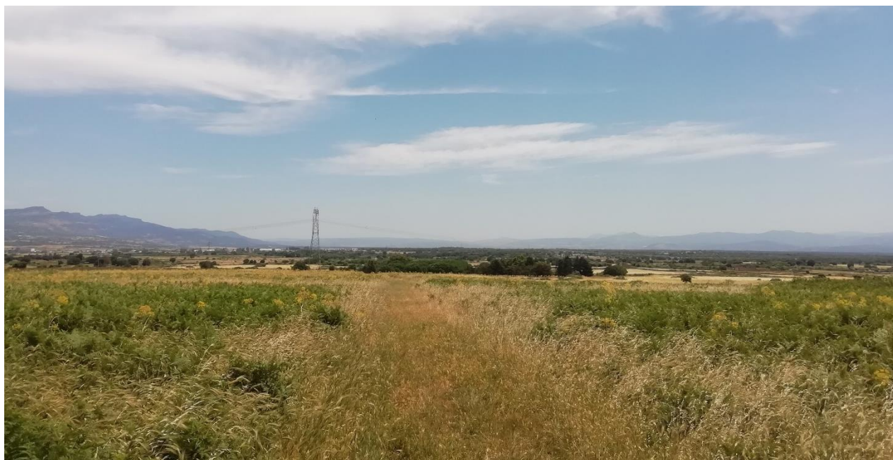
FIGURA 54: VISTA SUD-OVEST LOTTO 1
