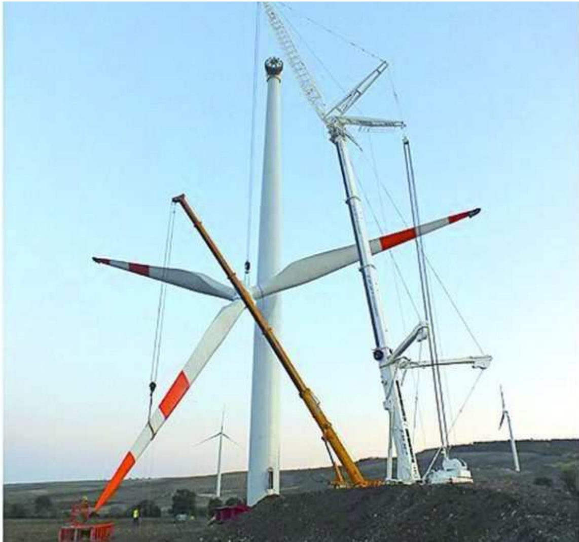
Foto 3, fase di montaggio dell'aerogeneratore (fonte sito La Molisana Trasporti)
