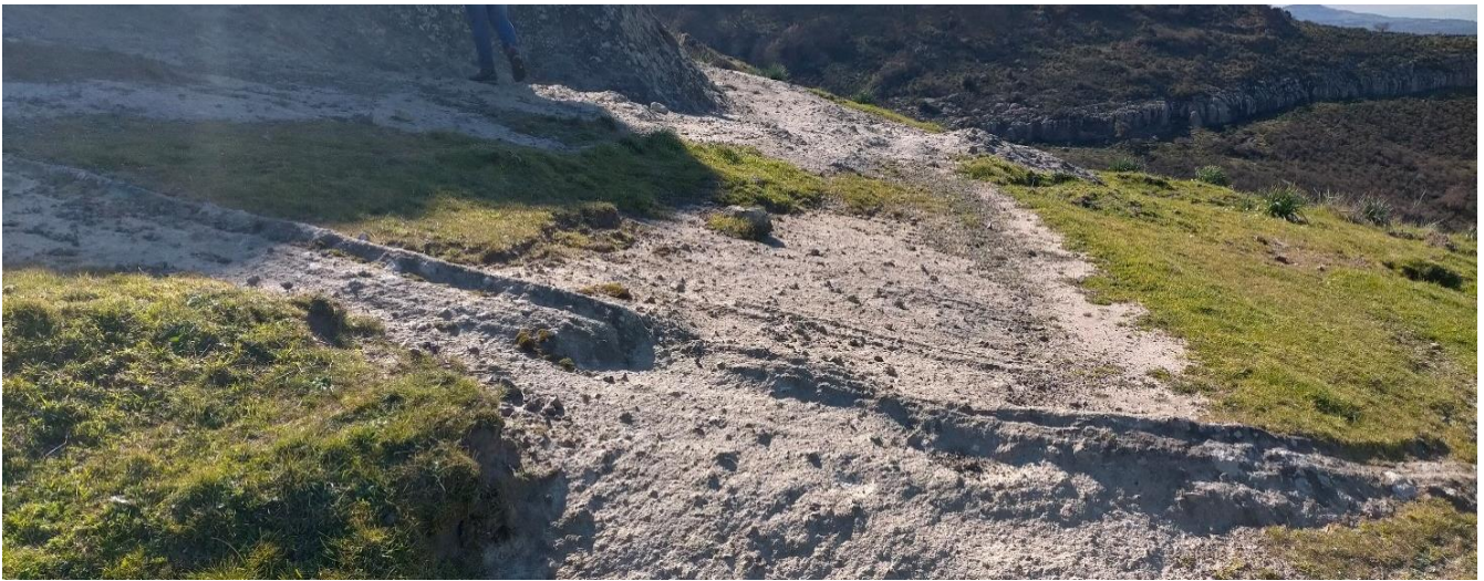
Figura 27 Erosione selettiva dovuta all'azione aggressiva dell'acqua nella roccia costituita da livelli di flusso piroclastico di differente competenza
