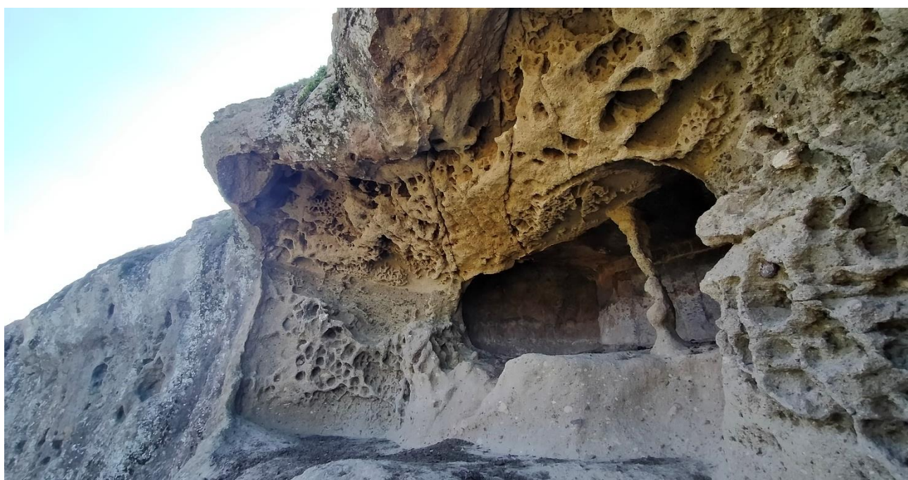
Figura 29 Parete appartenente alla Formazione del Monte Longos affetta da erosione vacuolare
