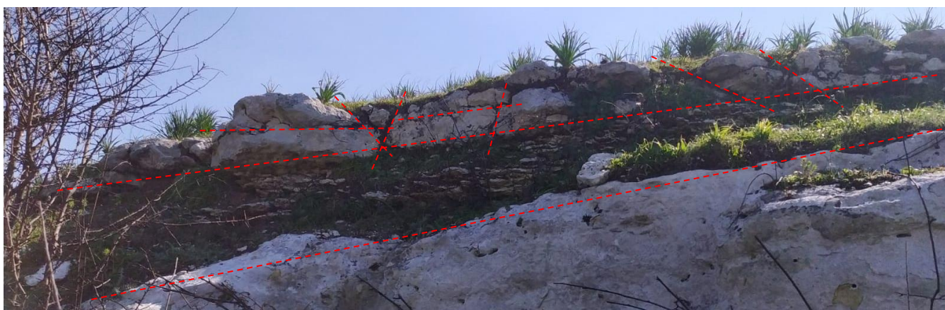
Figura 22 Livelli fratturati e alterati appartenenti alla Formazione di Monte Santo
