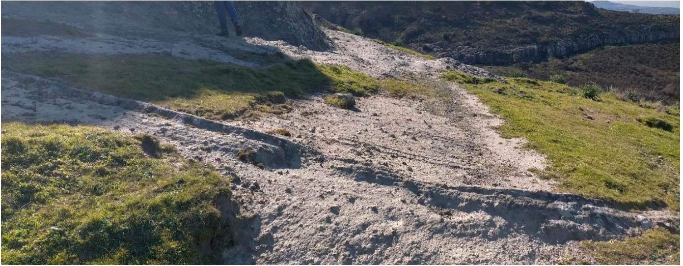
Figura 28 Erosione selettiva dovuta all'azione aggressiva dell'acqua nella roccia costituita da livelli di flusso piroclastico di differente competenzaza
