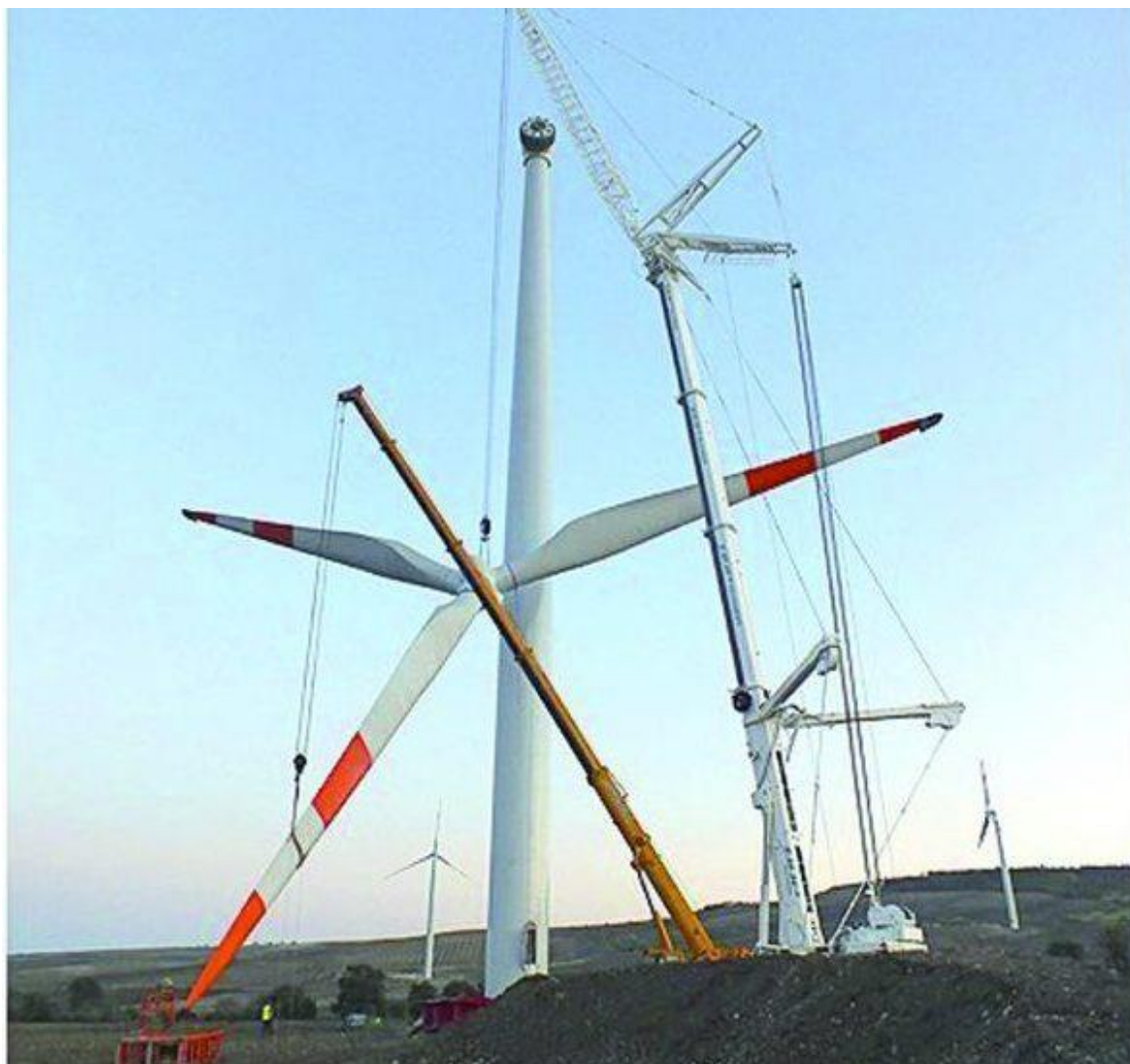
Figura 10: rappresentazione della fase di montaggio dell'aerogeneratore.
