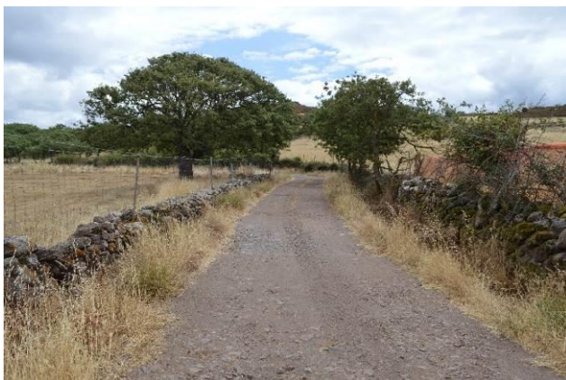
Figura 38 – Muretti a secco lungo tratto di viabilità da adeguare
