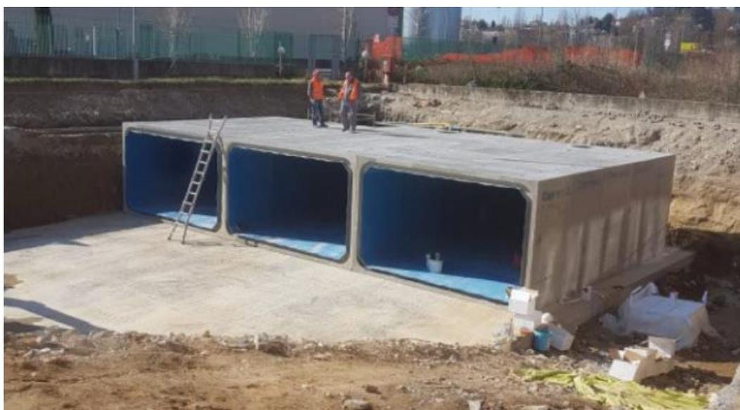
Fig.4: Serbatoio delle acque piovane in costruzione
