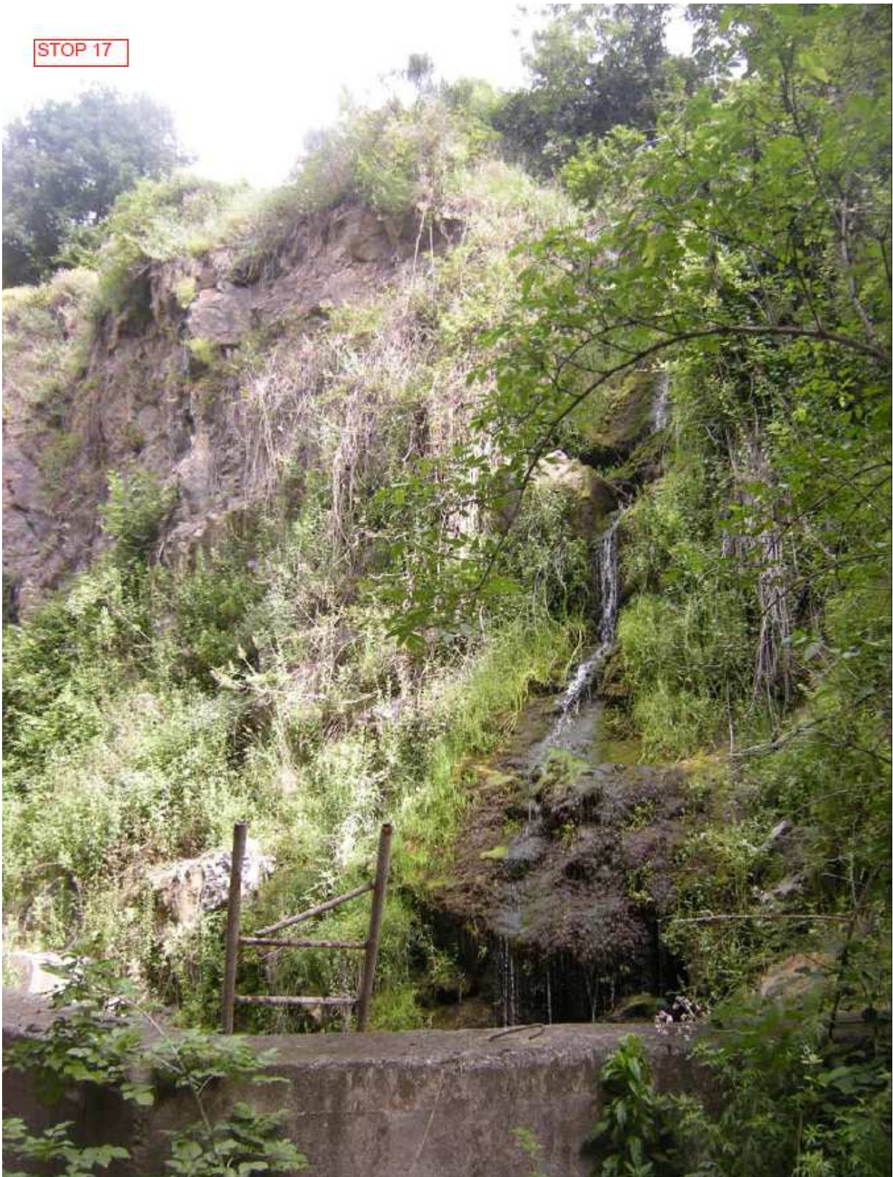
Figura 4-1: Affioramento zona imbocco intermedio lato Borzoli – Metabasalti
