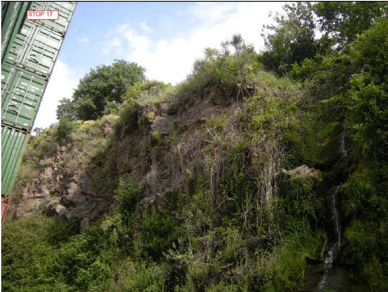
Figura 4-2: Particolare affioramento zona imbocco intermedio lato Borzoli – Metabasalti
