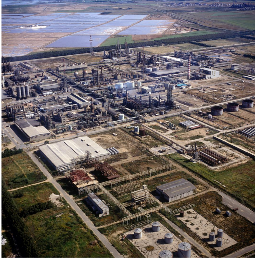
Fig. 2: Foto delle prime attività industriali installate in Loc. Macchiareddu
