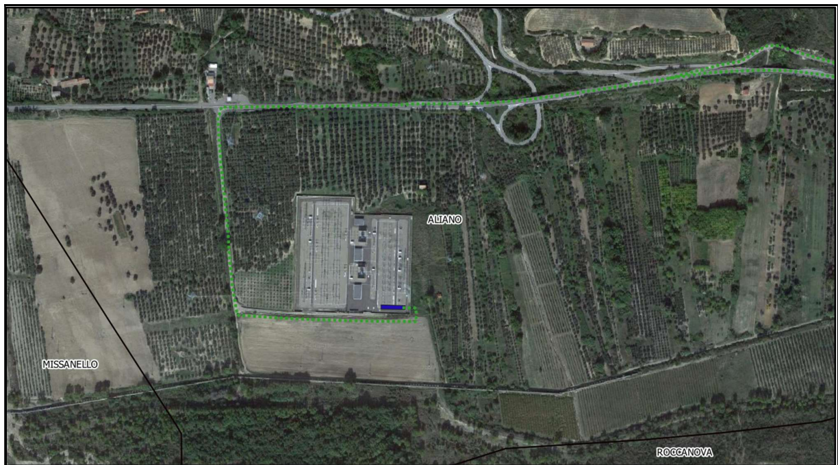
Figura 2.3.6.1: Individuazione su ortofoto dello stallo AT nella stazione Terna
