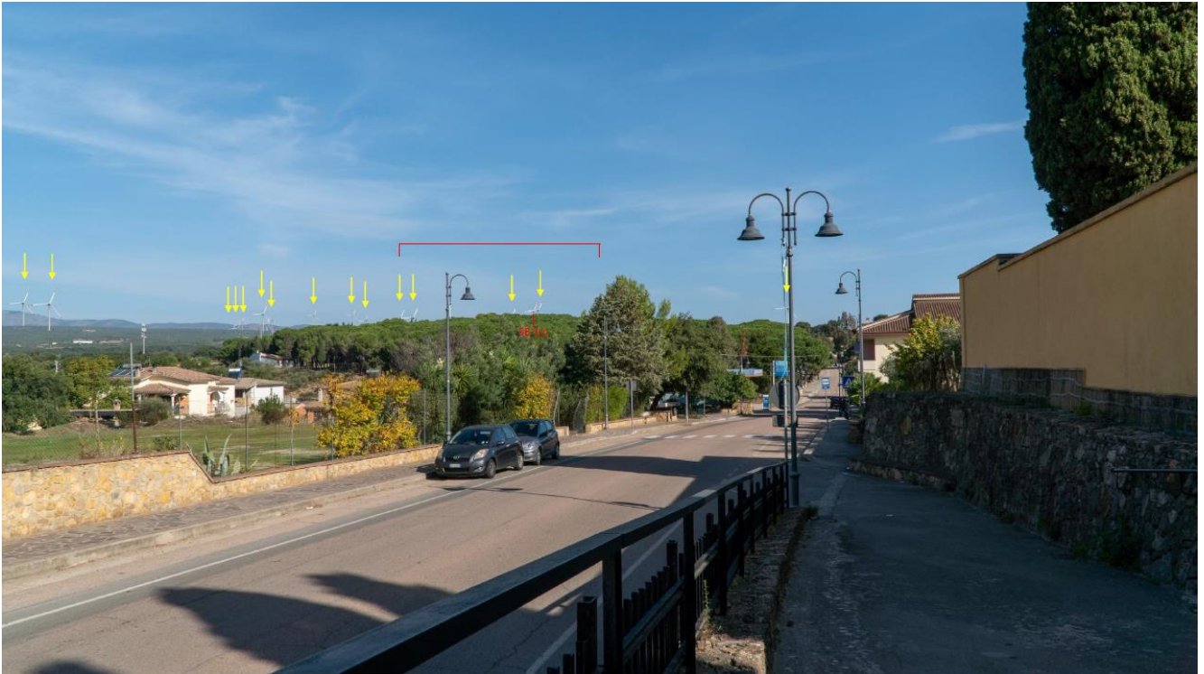
Fig. 80: PDV3 – ESCALAPLANO - CIMITERO - POST operam - La linea in rosso indica gli aerogeneratori in autorizzazione estranei al Proponente
